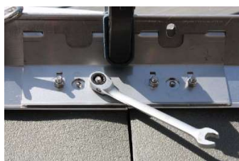
BILD 3. Placera skarven till sidoprofilen på sin platts enligt bilden och skruva lätt fast låsmuttrarna. Spänn jämt alla fyra muttrar turvis, tills dom är spända. Använd handverktyg för att dom syrefasta bultarna inte skall bli för heta och skära fast.
