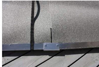
BILD 2. Skjut in flikarna mellan cellplasten och skurmattan på följande block, med det samma som du placerar blocken intill varandra. Montera skarvarna till mitt-profilen.
