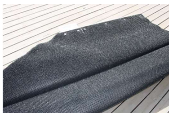
BILD 5. Fortsätt att vända så att övre halvan av mattan ligger mot marken enligt bilden och vänd till sist upp den andra sidoprofilen. Montera därefter resten av sidoskarvarna.
