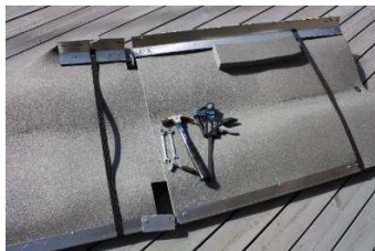
BILD 1. Börja arbetet med att placera blocken efter varandra på ett jämt underlag i ordningen, framdelen, förlängning/förlängningar och bakdelen. Hantera cellplasten varsamt.
