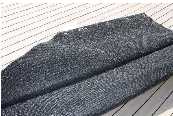
BILD 5. Fortsätt att vända så att övre halvan av mattan ligger mot marken och vänd till sist upp den andra sidoprofilen. Montera därefter resten av sidoskarvarna.
