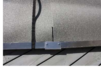
KUVA 2. Pujota lohkojen liepeet seuraavan lohkon solumuovin alle, samalla kun asettelet lohkot toisiinsa kiinni. Kiinnitä alareunan liitoskappaleet.
