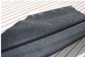
KUVA 5. Käännä tämän jälkeen ylempi puolisko kokonaan kuvan mukaisesti alustaa vasten ja jatka kääntämällä toisen puolen sivuprofiili päällimmäiseksi. Jatka nyt toisen reunaprofiilin liitospalojen asennusta.
