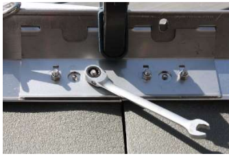
KUVA 3. Aseta reunaprofiilin liitospala kuvan mukaisesti paikalleen. Kierrä lukkomutterit kevyesti paikalleen. Kiristä kaikki neljä lukkomutteria tasaisesti vuorottelemalla kiinni. Käytä käsityökaluja, ettet kuumenna kierteitä liikaa.
