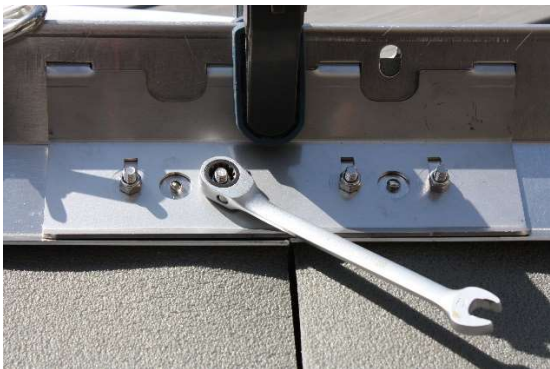
KUVA 3. Aseta reunaprofiilin liitospala kuvan mukaisesti paikalleen. Kierrä lukkomutterit kevyesti paikalleen. Kiristä kaikki neljä lukkomutteriä tasaisesti vuorottelemalla kiinni. Käytä käsityökaluja, ettet kuumenna kierteitä liikaa.
